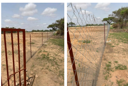
家畜等による食害防止のための柵 (H=1.5m)を設置
