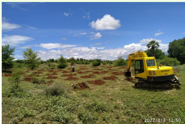
ショベルカーを使った植え穴掘り
