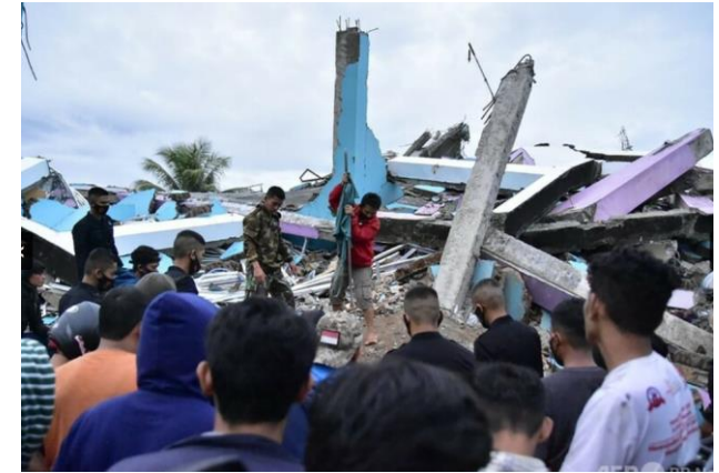
2021年スラウェシ島地震で倒壊した病院
