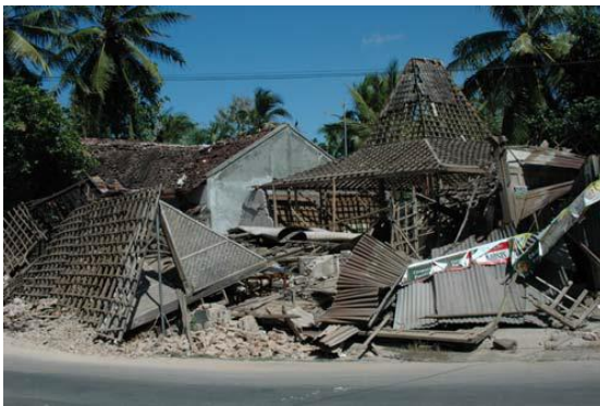
倒壊したRC柱 レンガ組住宅
