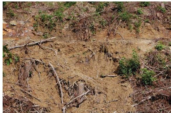
写真-I-12 根株を埋めて作設された作業道
