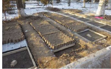
⑤ 保育ブロックを苗床へ設置
