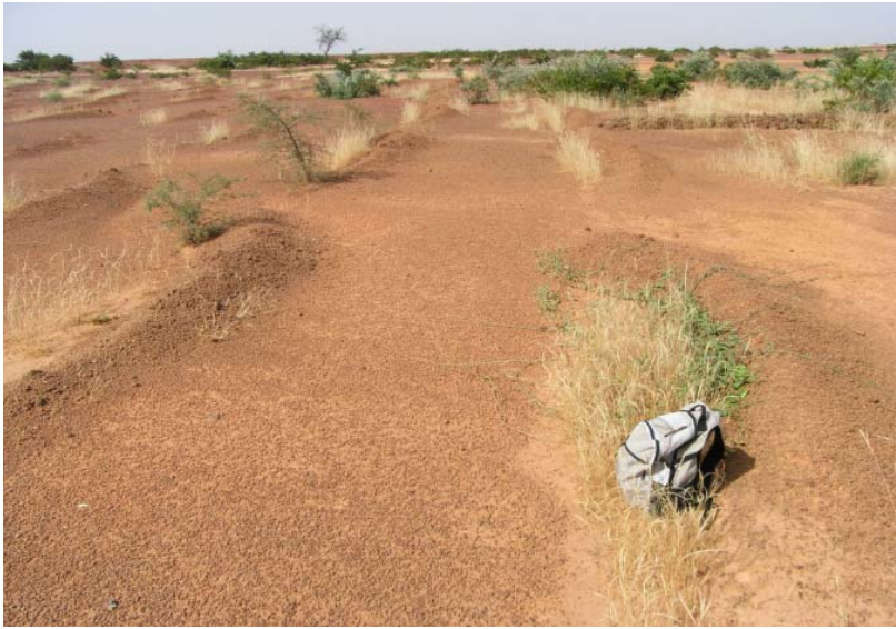
写真4 上流に湾曲させた三日月型の集水土堤（ブルキナファソ）
