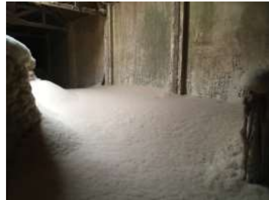
繊維の吹き出しが終わったブロー内
