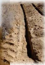
植栽前に 灌水用の 溝を設置
