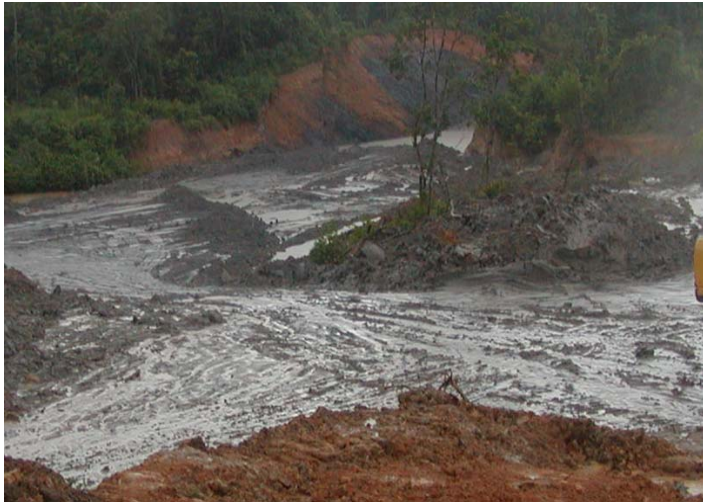
写真 3-2-1 AGM における試験地造成の様子。
