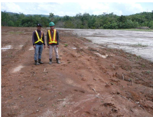
写真 2-3. AGM 社平成 25 年度対象地 全面客土区 (左側)
