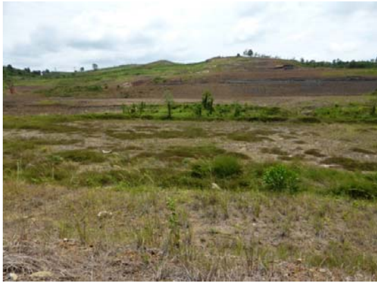
写真 6-4-7. 種子吹き付け工法（遠景） 茶色の部分は、土壌 pH4.0 未満のため不適
