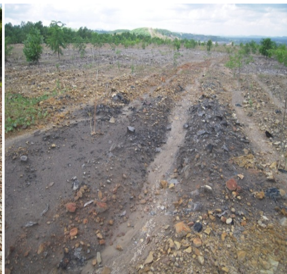
写真 3-2-7 TAJ リッピング区では凸部の細粒物質が凹部へ再堆積し、雨水は凹部沿いに緩やかに排水される。
