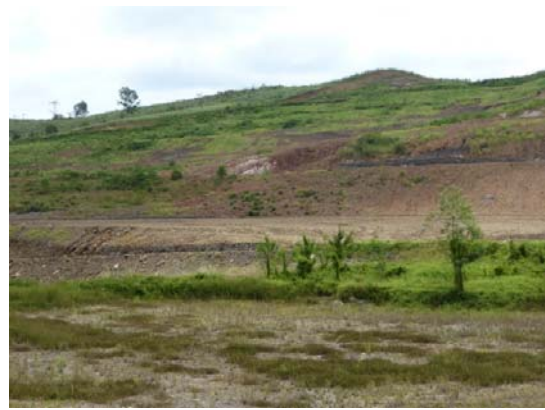
写真 6-4-8. 種子吹き付け工法（近景） 一部（茶～こげ茶～黒色）は植生が未回復
