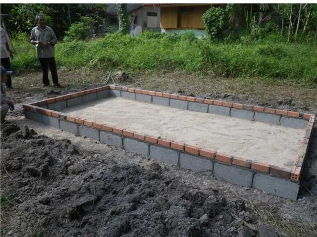
湛水馴化処理用のプール（コンクリートブロック・レンガ製、防水シートで覆う前、タイ、ナコンシタマラート県チャウアウト）
