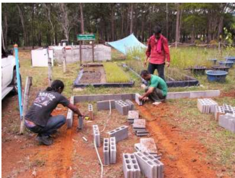
写真 10 プールの外枠のコンクリートブロックを配置
