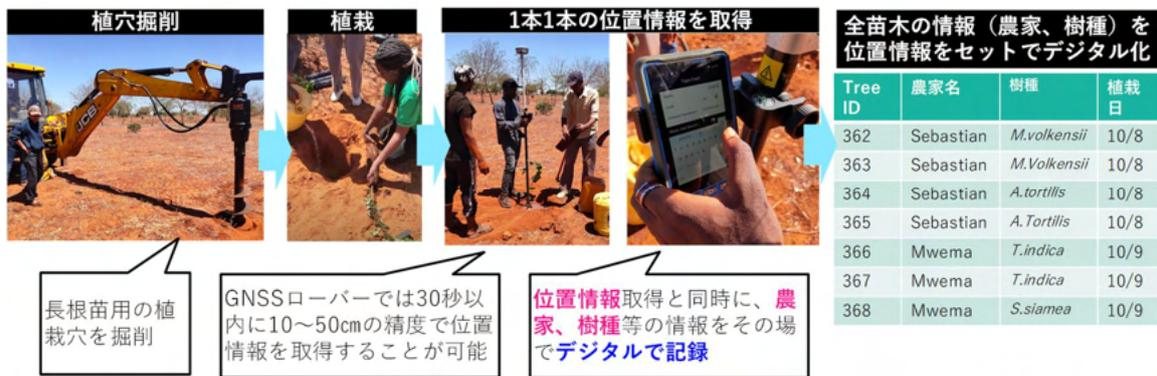
図 4-19 GNSS ローバーを用いた植林木の位置情報取得方法
