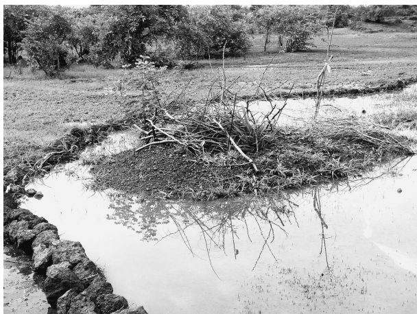
写真 4 石組みを設置し表土流出を防ぐ
