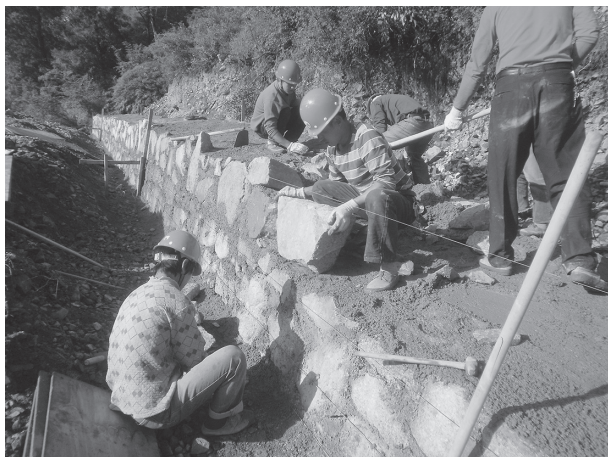
写真 5 練石積土留工施工指導
