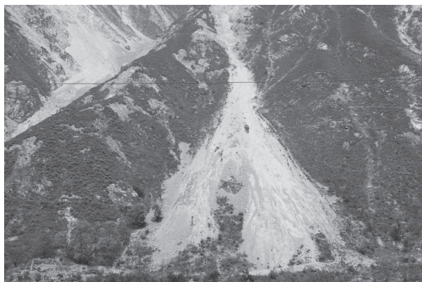
写真 2 ブン川施工前
