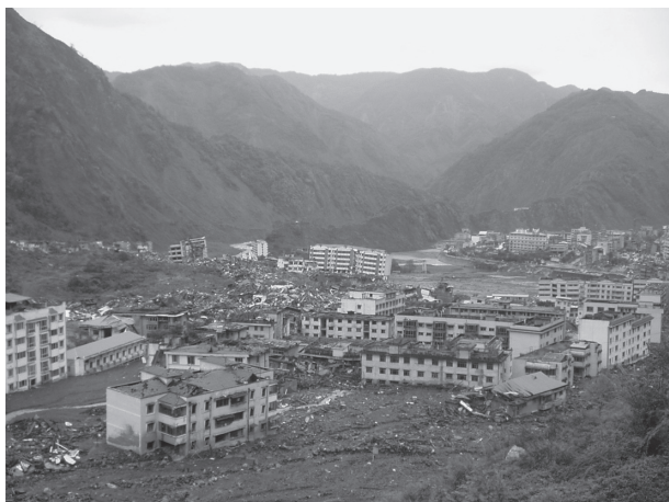
写真 1 地震による被害状況
