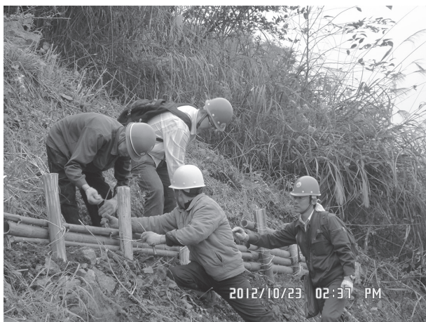
写真 4 専門家による施工指導
