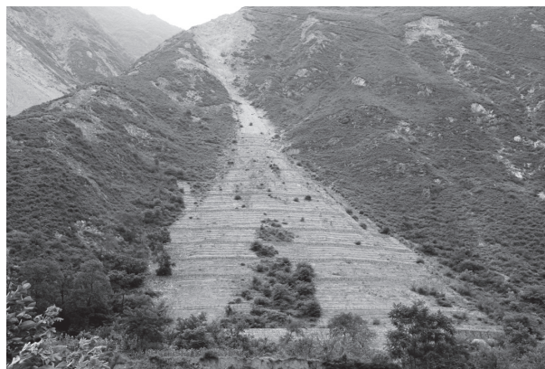
写真 3 ブン川施工後
