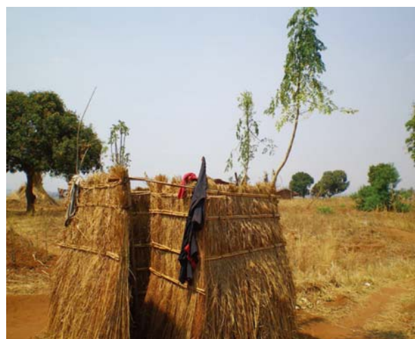
写真 4 風呂場のフェンスのポールとして利用されている
