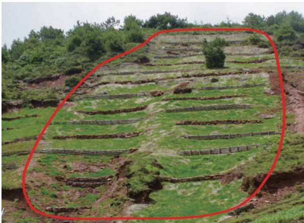
写真 6 簡易治山のモデル施工地
