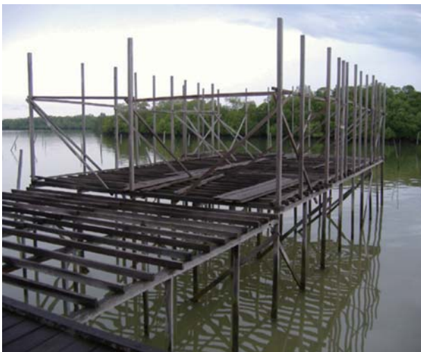
写真 5 ポンタン・クアラ地区の建築途中の家屋
