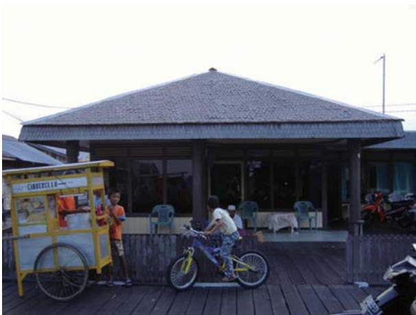
写真 1 こけら板屋根
