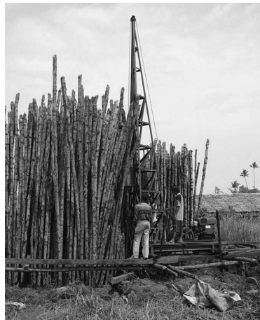
写真 3 基盤土壌に打ち込まれる大量のヒルギ材
