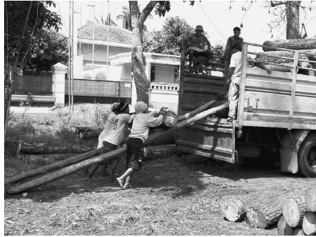
写真 2 人力による積み込み
