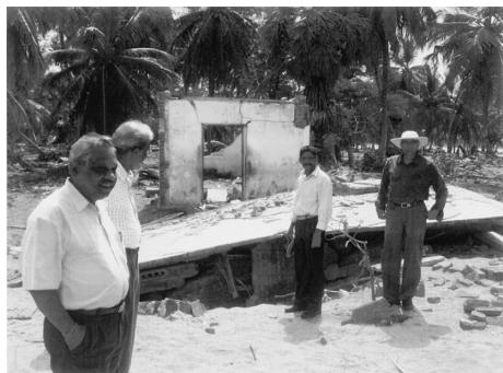
写真6 津波により基礎地盤が洗掘され、1階部分が沈降埋没した住宅 (スリランカ)
