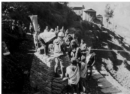
写真 2 村人の参加で設置されたロープライン
