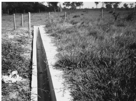
写真 8 侵食プロット斜面の下端に設けられた集水用トレンチ
