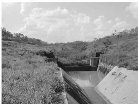
写真10 ガリー侵食防止工事から3年が経過して植生が回復した状況
