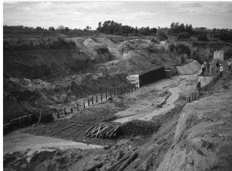
写真9 ガリー侵食防止工事（現場資材を活用して床固工と護岸工を実施）
