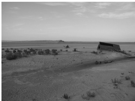
写真 3 ダム崩壊現場
