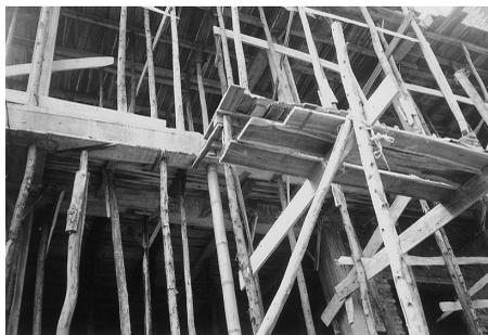
写真 4 ビル建築に使われる間伐材型枠
