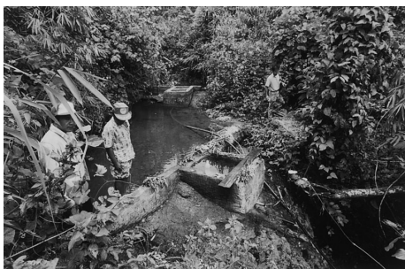
写真 4 簡易水道の取水堰 FORCAP が資材を提供、郡保健事務所が設計、村人が建設作業を行った
