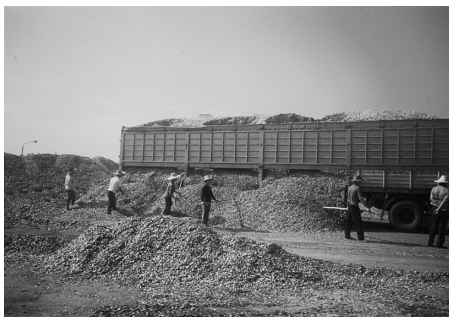
写真 3 チップの荷下ろし
