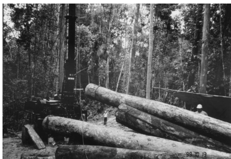
写真 4 タワーヤード架線集材システムによる集材試験
