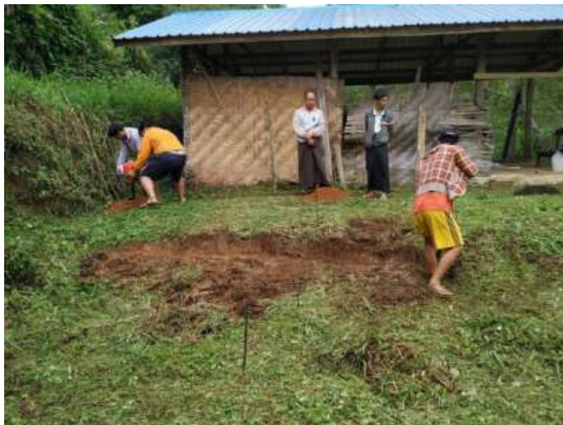
図 1-1-13 モンゴック苗畑の建設状況
